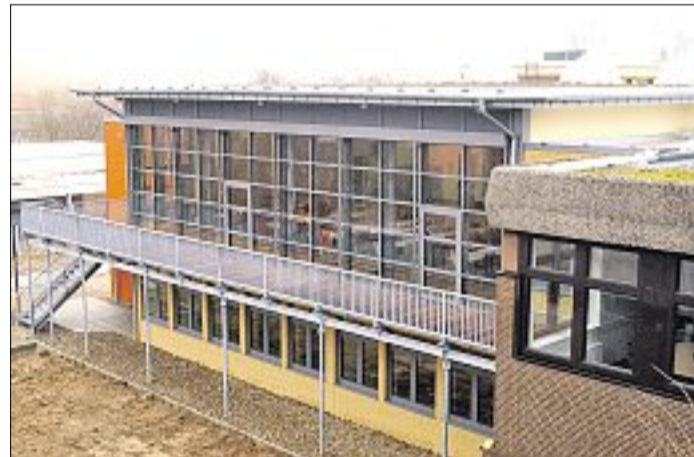
Die Außenanlage ist noch nicht fertig, der Anbau schon.
